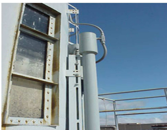
شکل ۱۷- چشمه نقطه ای - آشکارساز میله ای: برای اندازه گیری پیوسته سطح
